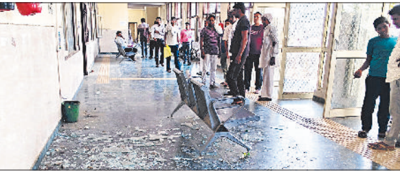
कलायत। उप मंडल मुख्यालय भवन के अंदर शीशे टूटने से सहमे लोग।
